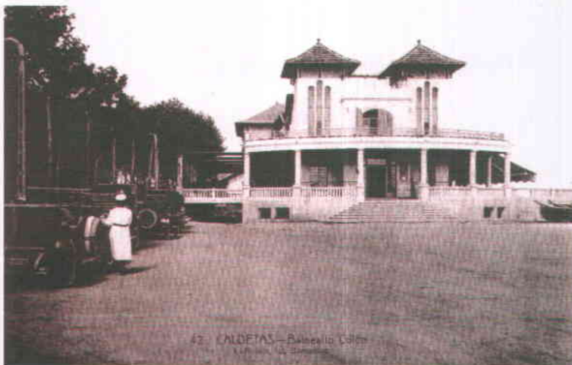
Fotografia núm. 6 – Façana accés del Balneari Colón amb la galeria/pèrgola que connecta amb el parc (esquerra de la fotografia). Any 1930.
