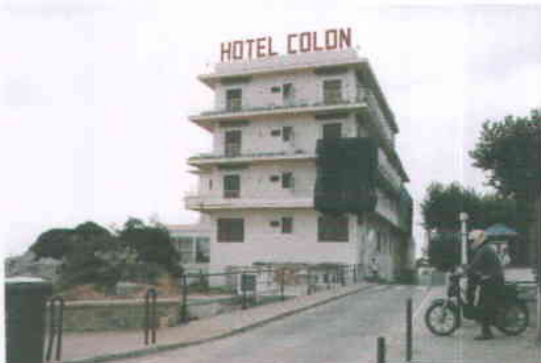
Fotografia núm. 19. Aspecte actual de l'edifici on s'evidencia el caràcter residual de les façanes que s'ofereixen a la banda est i al parc, havent-se perdut la funció urbana que l'antic edifici dels anys 30 aconseguia amb la porxada correguda que connectava la platja, el parc i el passeig dels Anglesos. Any 1998.
