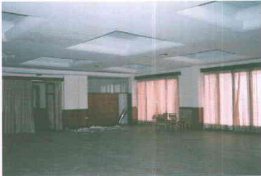
Fotografia núm. 20. Aspecte actual de la sala de ball, havent-se suprimit el doble espai i qualsevol element decoratiu dels que significaven l'antiga edificació. Any 1998.
